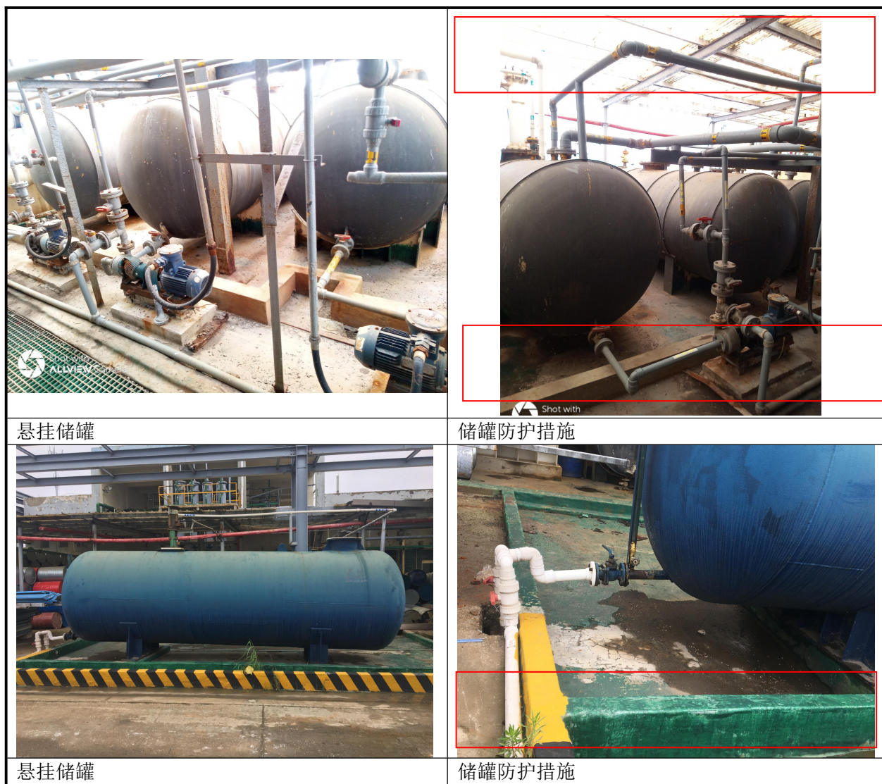
图 5-2 离地的储罐及防护措施情况
