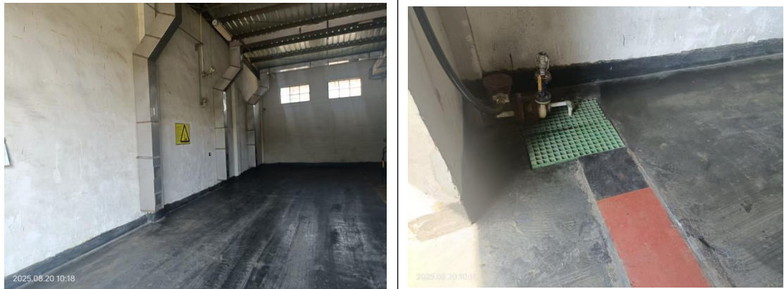
图 4-9 现场照片（危废仓库）
