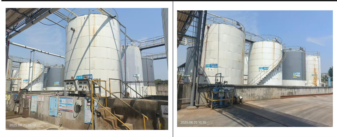
图 4-1 现场照片（储罐区）
