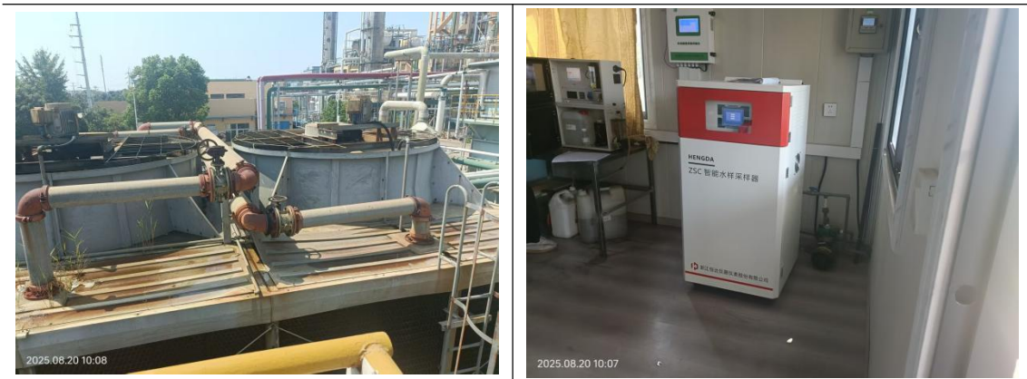
图 4-7 现场照片（废水处理）
