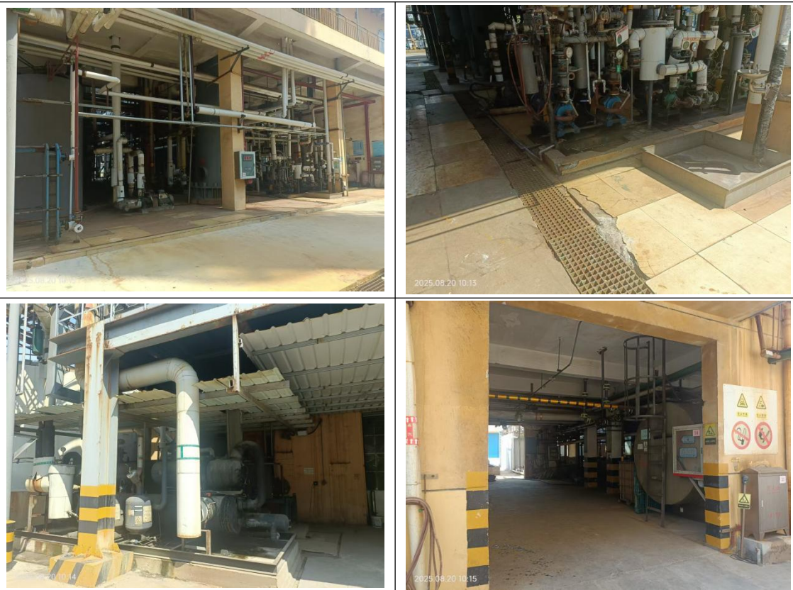
图 4-6 现场照片（生产区）
