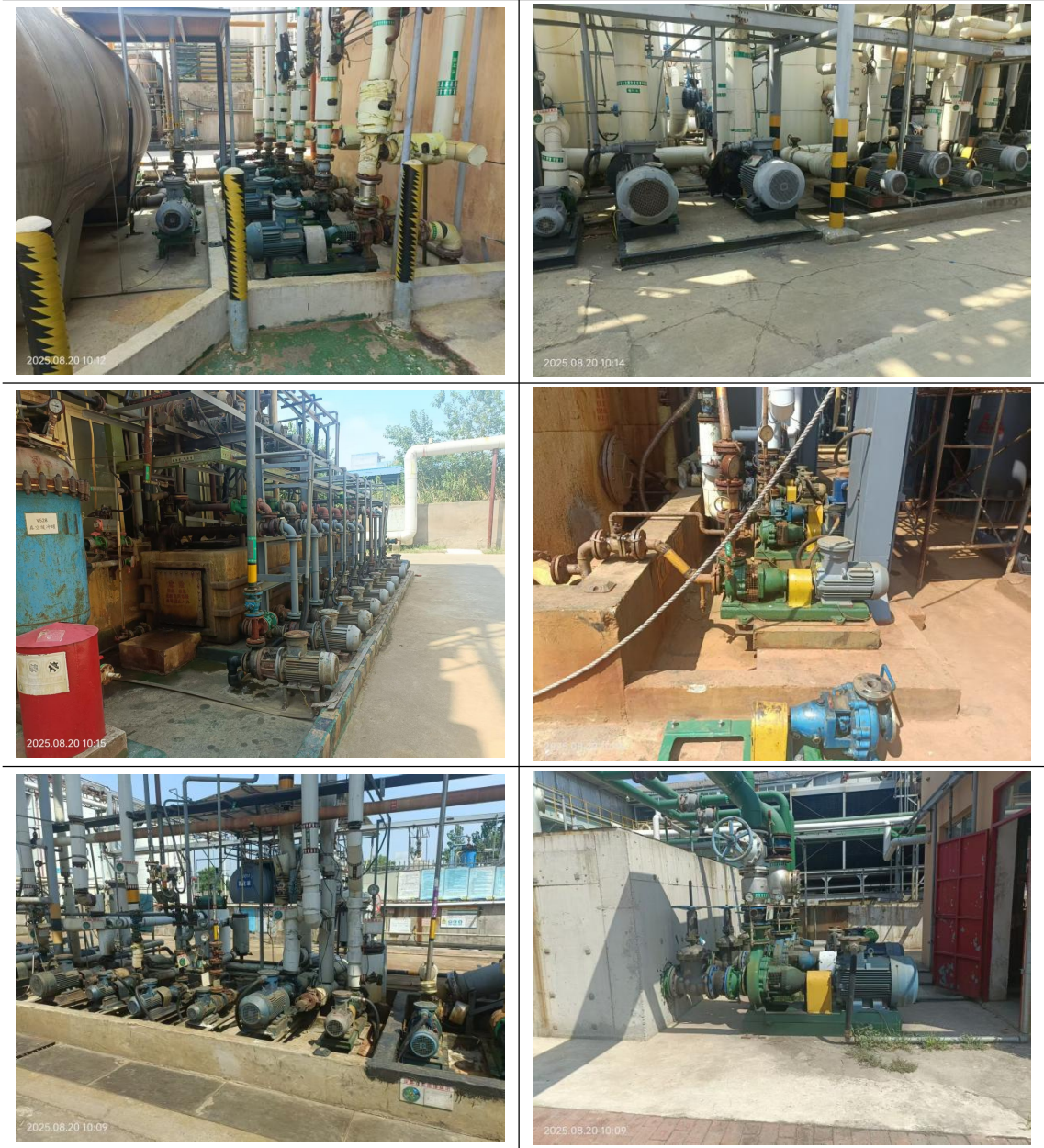
图 4-4 现场照片（泵传输）
